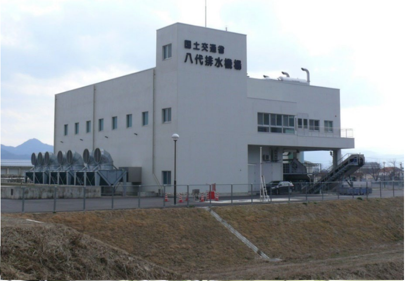
整備後 八代排水機場 4\text{m}^3/\text{秒} > 33\text{m}^3/\text{秒}
